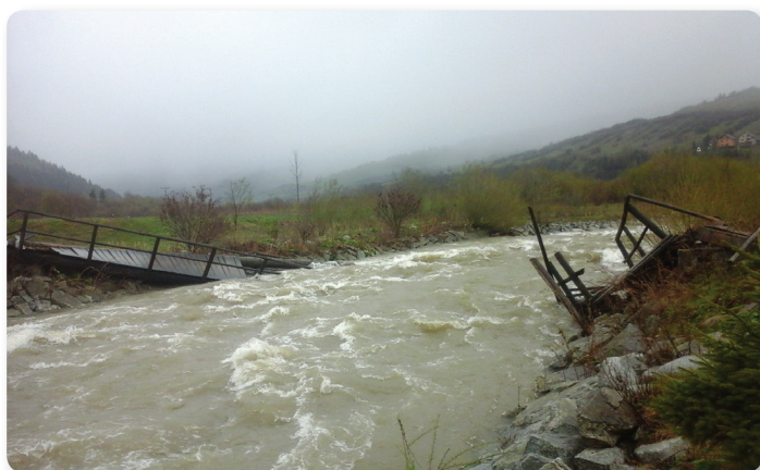
Rozvodnený Studený potok v apríli poškodil lavičku.
