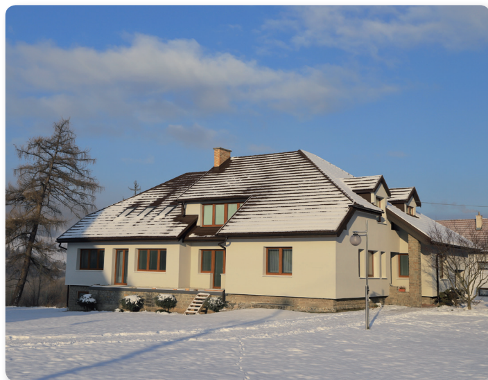
Vynovená farská budova
