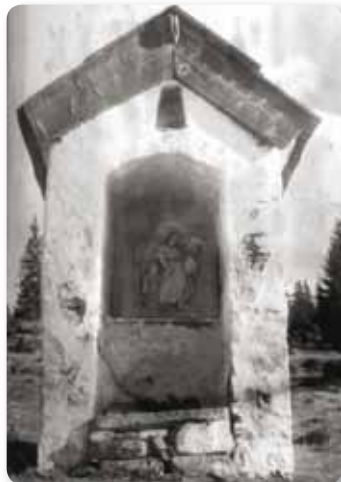
Kaplnka pred obnovou.
