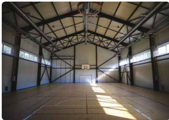
Interiér telocvične po kolaudácii.
